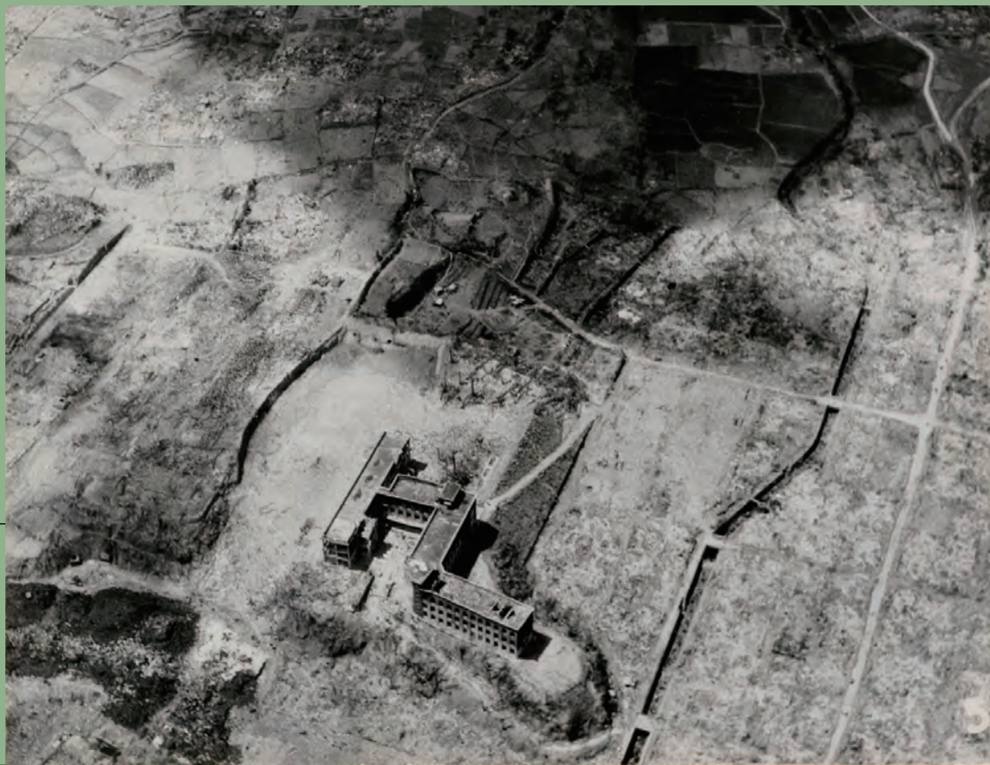
上空から見た被爆後の城山国民学校一帯 長崎原爆資料館所蔵
